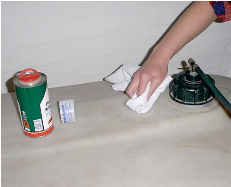
( 2 ) Appliquer un adhésif spécial et la pièce de montage coller sur le réservoir
