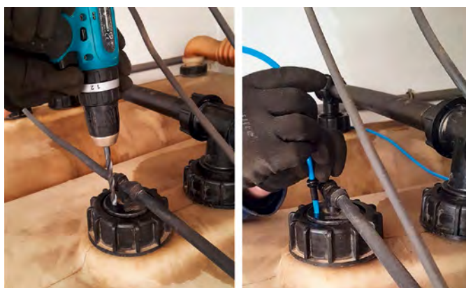
Bild 1: Einfache Nachrüstung der Tankmessleitungen des „secu4“ an der Tankarmatur.
